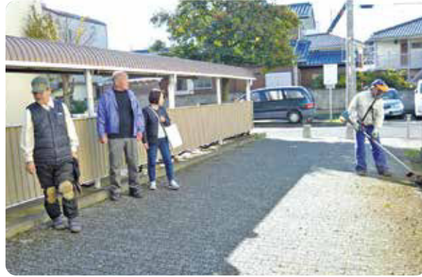
作業会員と現場を巡回した委員
